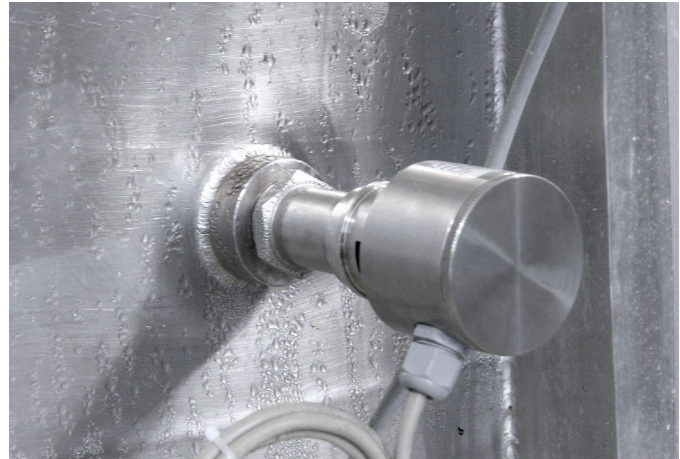
Das spezielle, hermetisch geschlossene Messsystem des LAR ist gegen Kondensat oder Feuchtigkeit vollständig geschützt.
