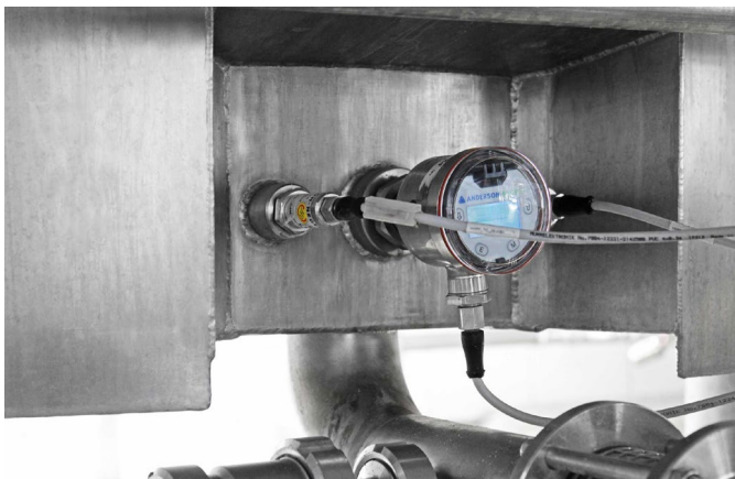
Gängige Praxis für Lager- und Reifetanks: Einfache Installation von hydrostatischem Füllstandsensoren (Hier L3 Neo), Temperatursensoren und Grenzstandmeldern an der Tankunterseite
