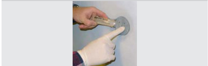
Abbildung 5-25 Rostschutzmittel auftragen
